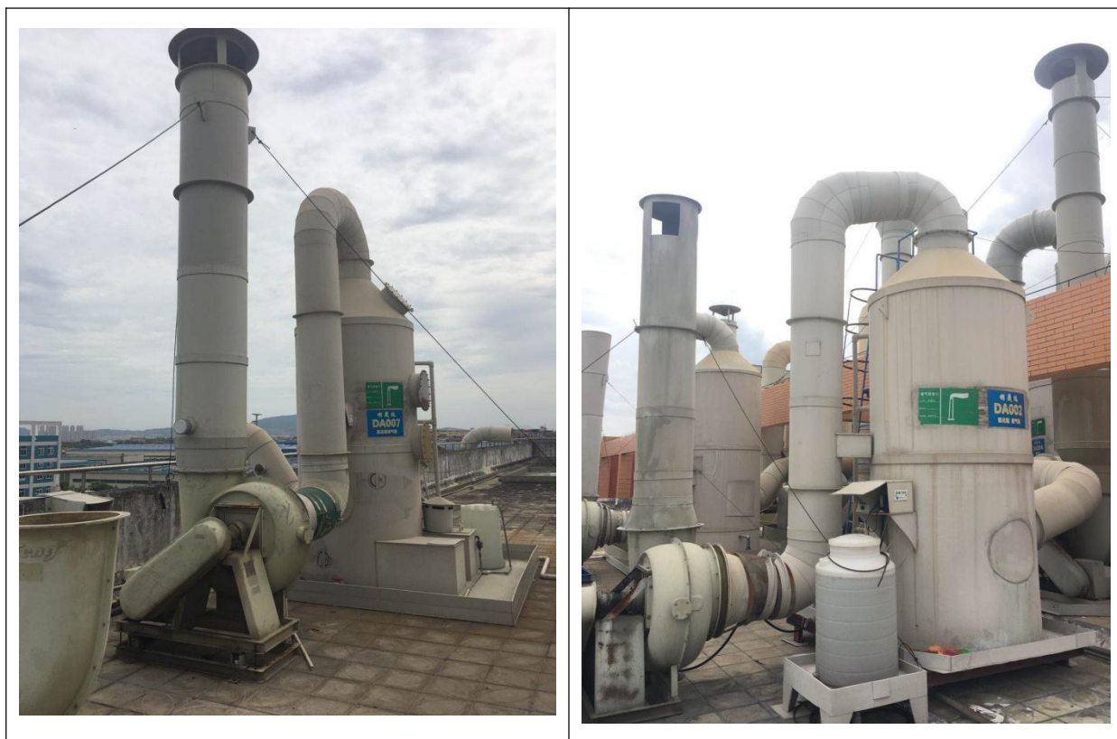
图 3.6.8 废气处理设施图
